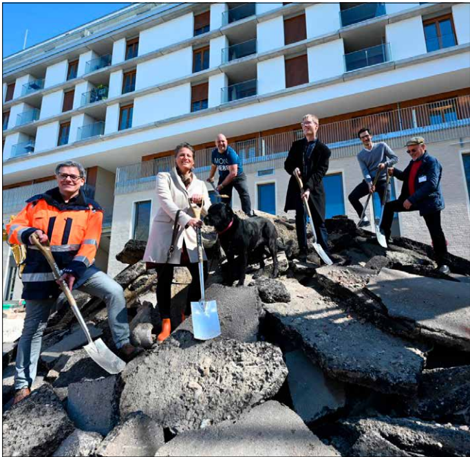
Asphalt raus, Pflaster rein: Bei der Sanierung des Platzes der Begegnung in Landwasser gibt es viel zu tun.
