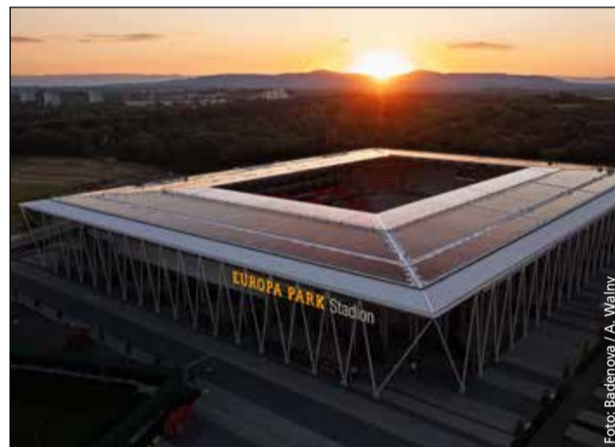
Zweimal zwei: Das neue Stadion ist nicht nur Spielstätte der aktuell zweitbesten deutschen Fußballmannschaft, sondern hat auch die weltweit zweitgrößte Solaranlage auf dem Dach.
