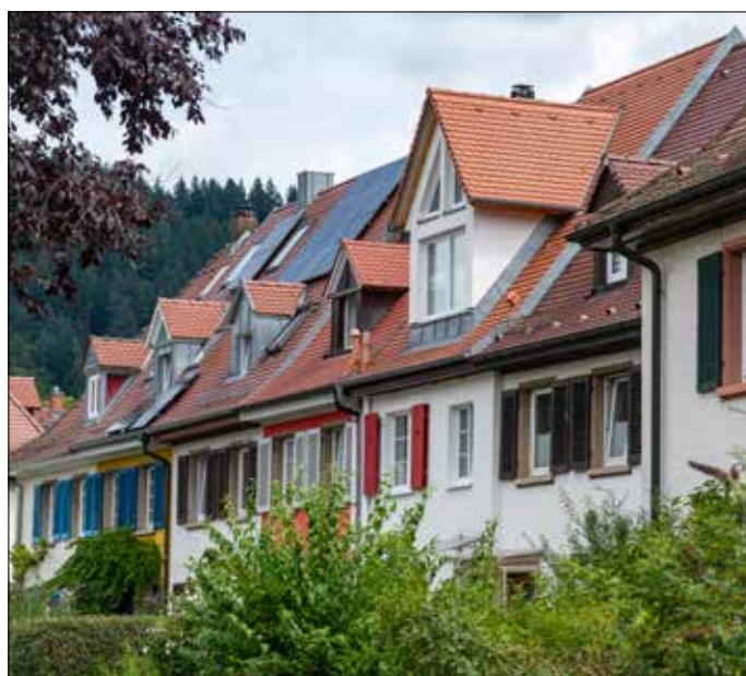
Auch im Waldsee: Dachausbau und Solaranlagen sollen nicht an bürokratischen Hürden scheitern, findet der Gemeinderat.
