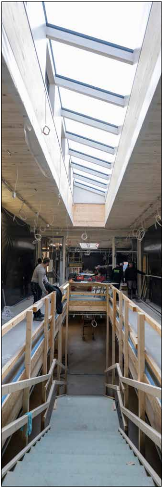
Noch Baustelle, bald Ganztagschule: die Anne-Frank-Grundschule in Betzenhausen.
