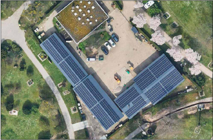
Auf sonnige Zeiten wartet die Photovoltaikanlage auf dem Betriebshof des Hauptfriedhofs. (Foto: Eigenbetrieb Friedhöfe)
