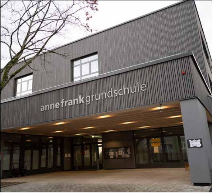
Wie neu: Auch von außen ist vom Altbau nichts mehr zu sehen.
